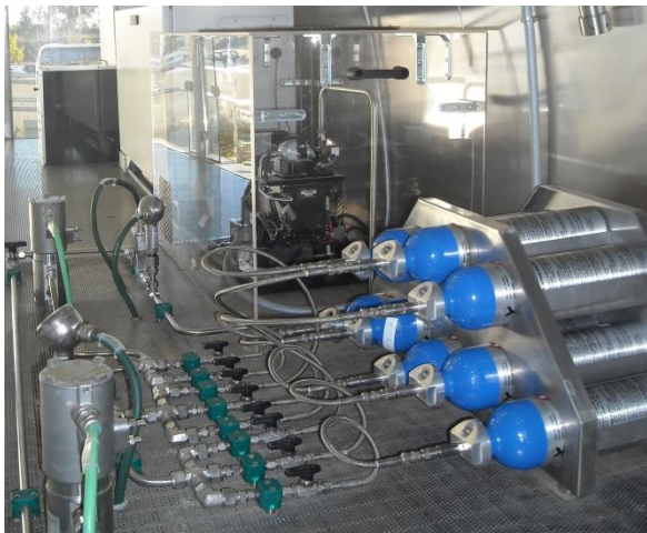
Bild 1: 8 Metallhydrid basierte H 2 -Tankmodule zur Speicherung von per Photovoltaik und Elektrolyse erzeugten Wasserstoffs vor der Rückverstromung (im Hintergrund) © Abengoa Hidrógeno, Sevilla, Spanien (Partner im BOR4STORE Projekt [6])
